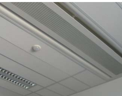
Installatie Koelbalk VFK 600
