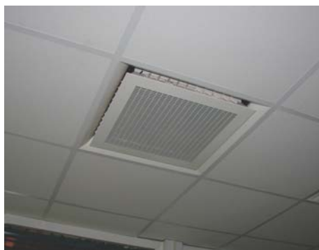
VFK-Q ingebouwd in verlaagd plafond
